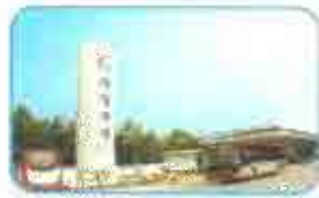
LNG 加气站 LNG Refueling Station
